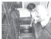
排水タンク清掃
