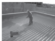
遮熱防止施工
