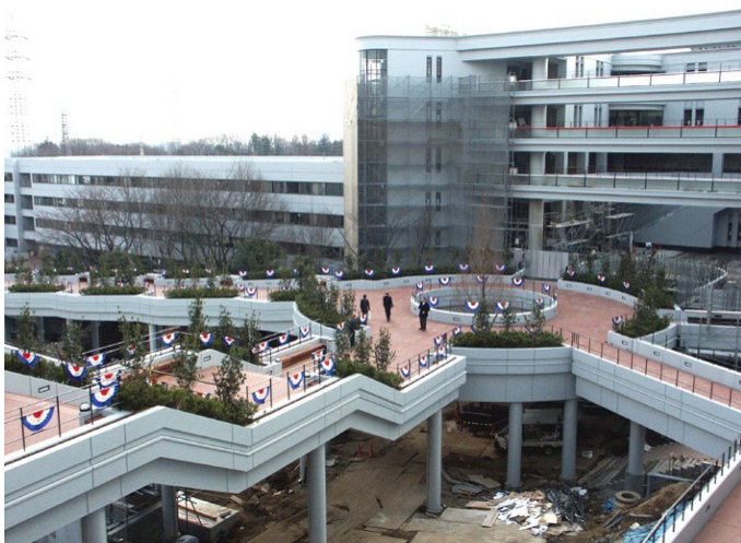
↑白門プロムナードと工事中の多摩学生生活関連棟（仮称）
