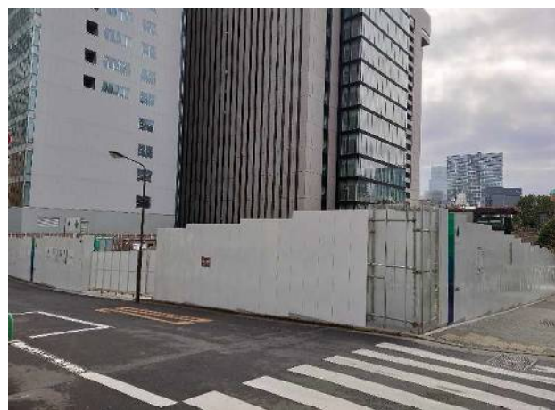
2021年1月駿河台新校舎の工事風景
