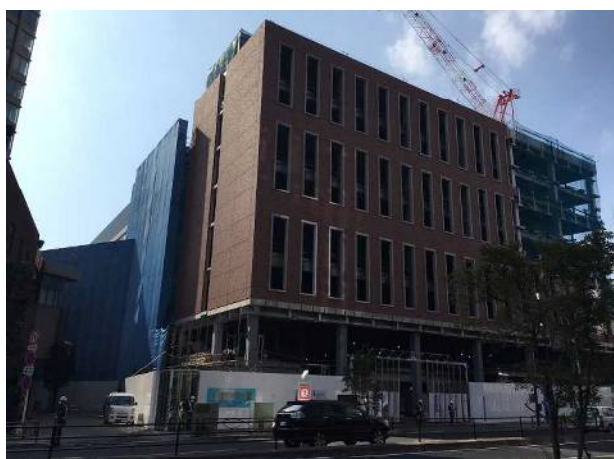
2022年2月 茗荷谷校舎の工事風景
