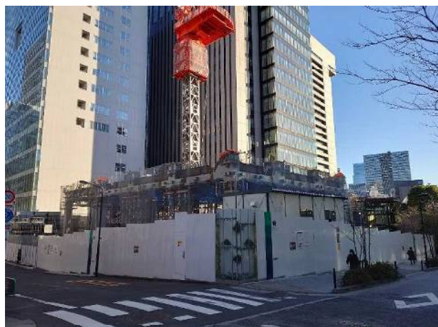
2022年2月 駿河台新校舎の工事風景
